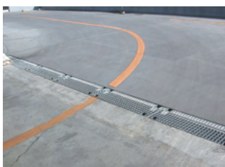
熊本市内立体駐車場 2005.7 施工
