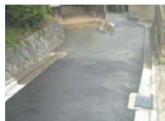
大阪府吹田市 2005.7 施工
