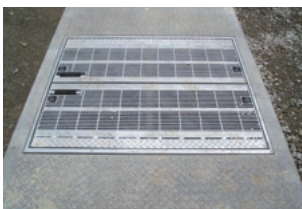
溝幅1000mm 香川県高松市 2010年4月施工
