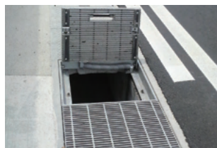
溝幅500mm 鳥取県米子市 2009年2月施工
