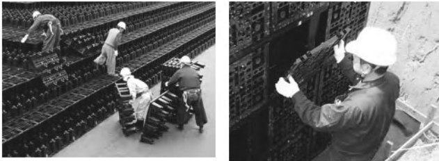
組立て作業の様子
