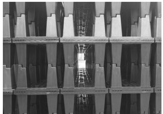
広いトンネル構造
