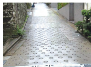
東京都渋谷区 2006.1 施工
