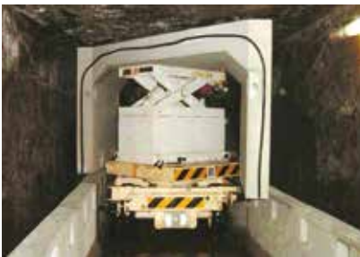
上部ブロックの据付施工
