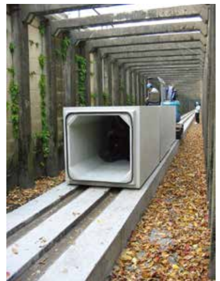
クレーン車不能使用の狭い場所での施工
