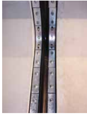
・可とう性継手構造の一例
