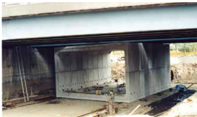
橋梁下での施工
