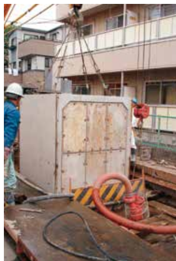
ボックスカルバートの据付
