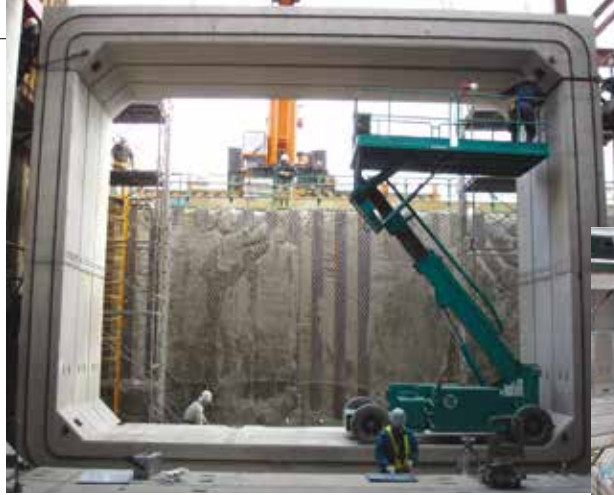
6分割ボックスカルバート／新中央卸売市場
