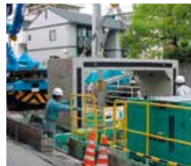
クレーンで函体吊下し
