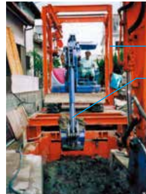
掘削機+函体吊下し設備搭載へ応用
