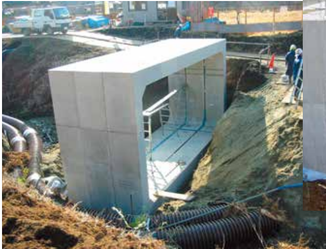
4分割ボックスカルバート／東京都町田市
