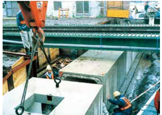
軌道下での施工
