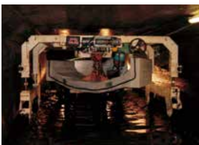
下水を流しながら施工
