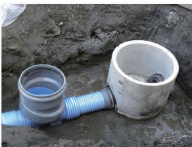
汚水ますとリップパイプの接合は、リップゴム可とうマンホール継手を使用
