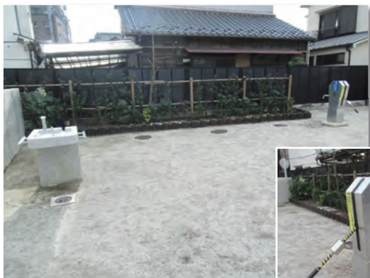
揚水ポンプと 洗浄ユニット貯水槽
