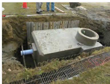
レジンコンクリート製貯留槽の設置
