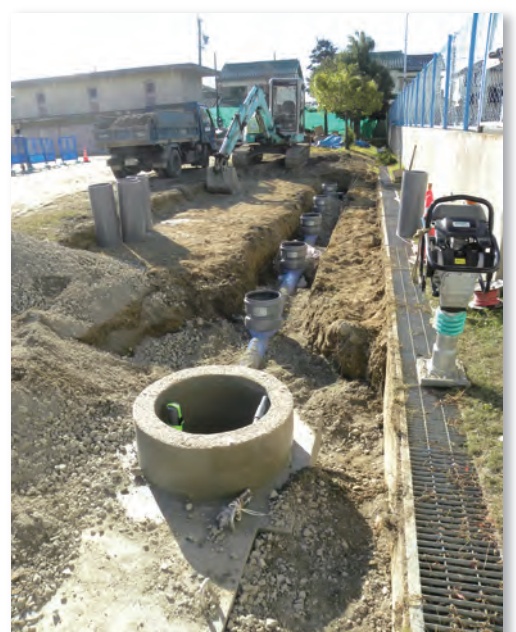
配管部分の完成
