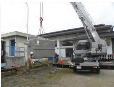
クレーンでの積み降ろし
