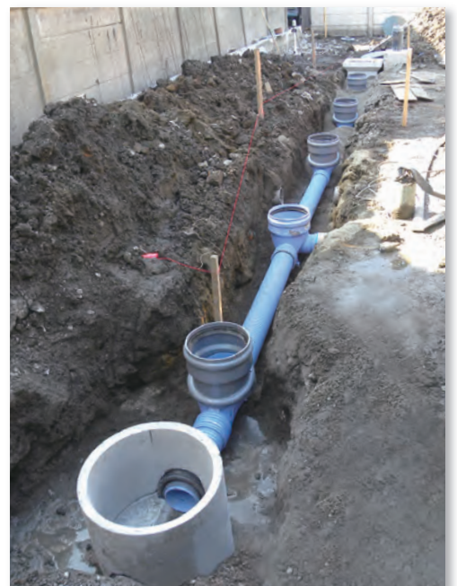
配管部分の完成
