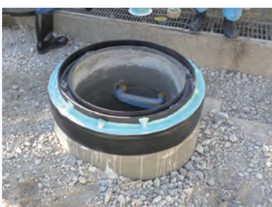
人孔をモルタルで製作し、止水処理を施して完成
