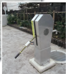
揚水ポンプと 洗浄ユニット貯水槽
