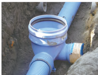
リップ付き小型マンホールは種類が豊富で、他の下水の合流も可能
