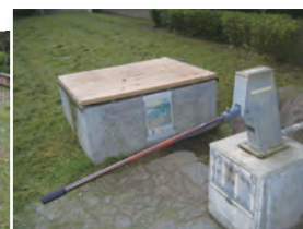
揚水ポンプと 洗浄ユニット貯水槽
